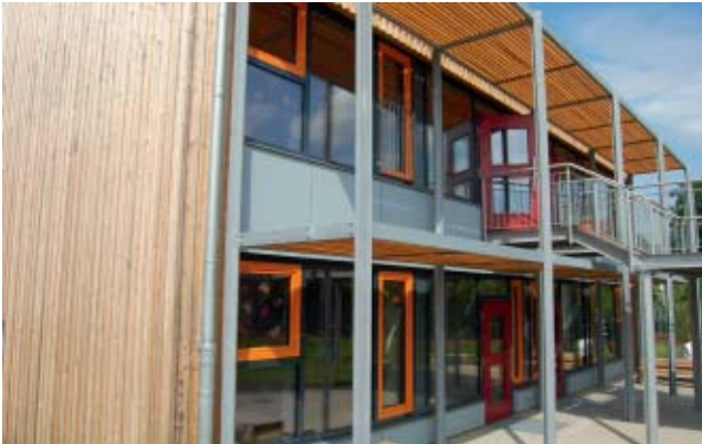
Passivhaus-Kindertagesstätte „Windröschenweg“ in Hannover-Seelhorst
